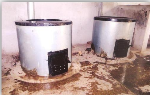
Einbau der neuen Kochstellen
